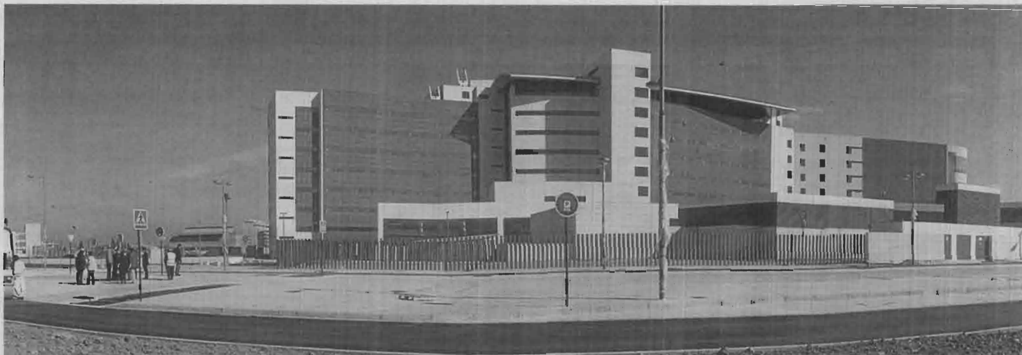
Vista general del nuevo hospital Clínico del PTS, que lleva terminado y sin funcionar desde 2010. ■ GONZÁLEZ MOLERO
